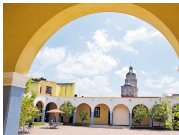
El área expositiva es de una estructura reticular con salas conexas
